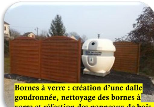
Bornes à verre : création d'une dalle goudronnée, nettoyage des bornes à verre et réfection des panneaux de bois.
